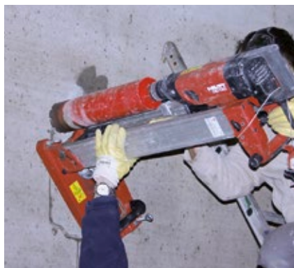
Odběr vzorku jádrového vývrtu v rámci dlouhodobého vyšetřování systému MC-RIM
